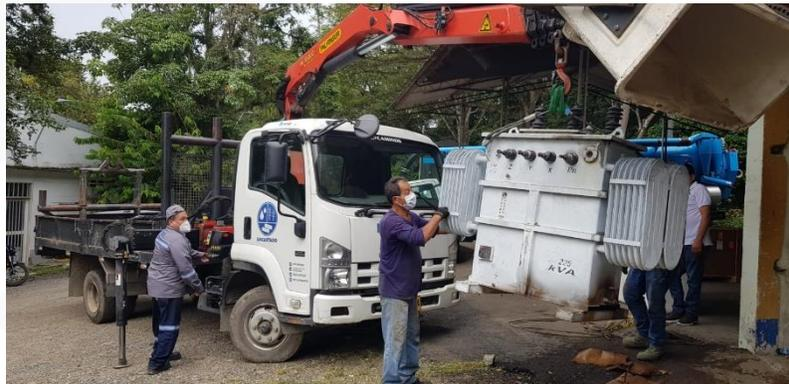
De acuerdo con lo proyectado y buscando tener un plan de contingencia mientras se realiza todo el proceso de remodelación y reposición de los transformadores del Bombeo por parte del proveedor que está realizando el proyecto y los diseños del mismo, Energía de Pereira y EMCARTAGO coordinaron la recogida del transformador de 225 KVA que se retiró del bombeo Guayabal, para efectuar el mantenimiento correctivo y reconstrucción para conservarlo como suplencia de los
