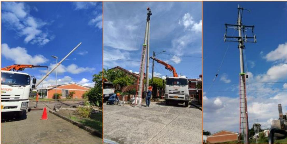
Foto1. Cambio e instalación de postes en el sector de Reservas del limonar, Santa Fe y el Diamante.
