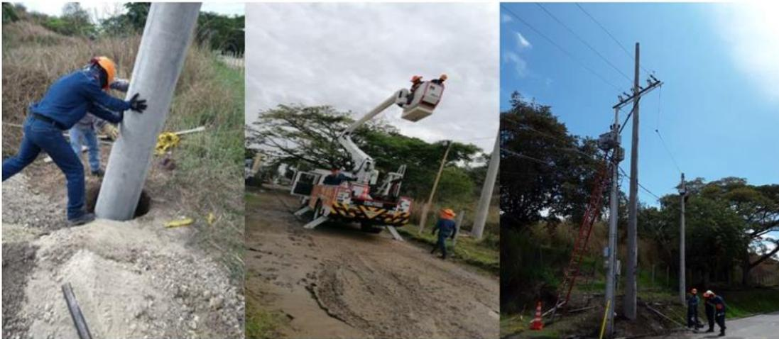
Imagen 2. Instalación de postes y conjuntos para el Local 3-Etapa1
