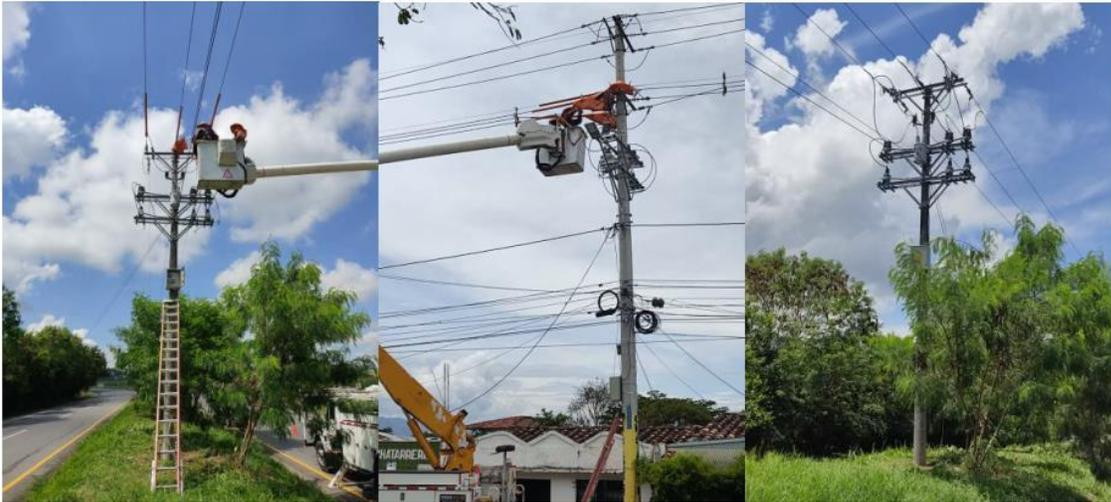
*Imagen 2. Instalación de equipos para la detección de ausencia de tensión (macromedidores).*
