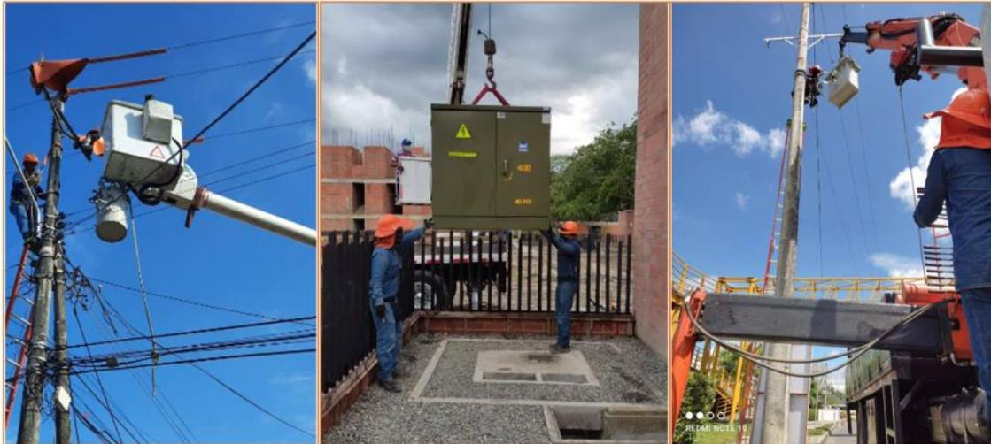
Foto 4. Instalación de transformadores en el SDL del municipio de Cartago
