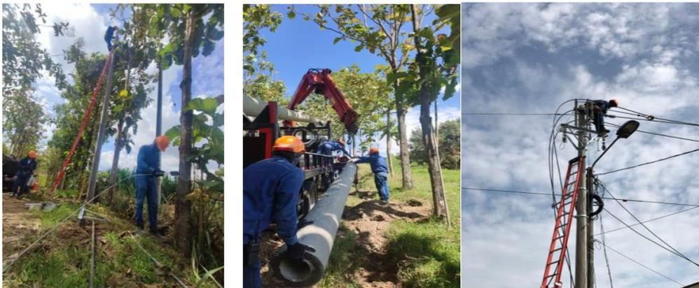
Imagen 1. Instalación de postes y estructuras en suplencia para el Bombeo.
